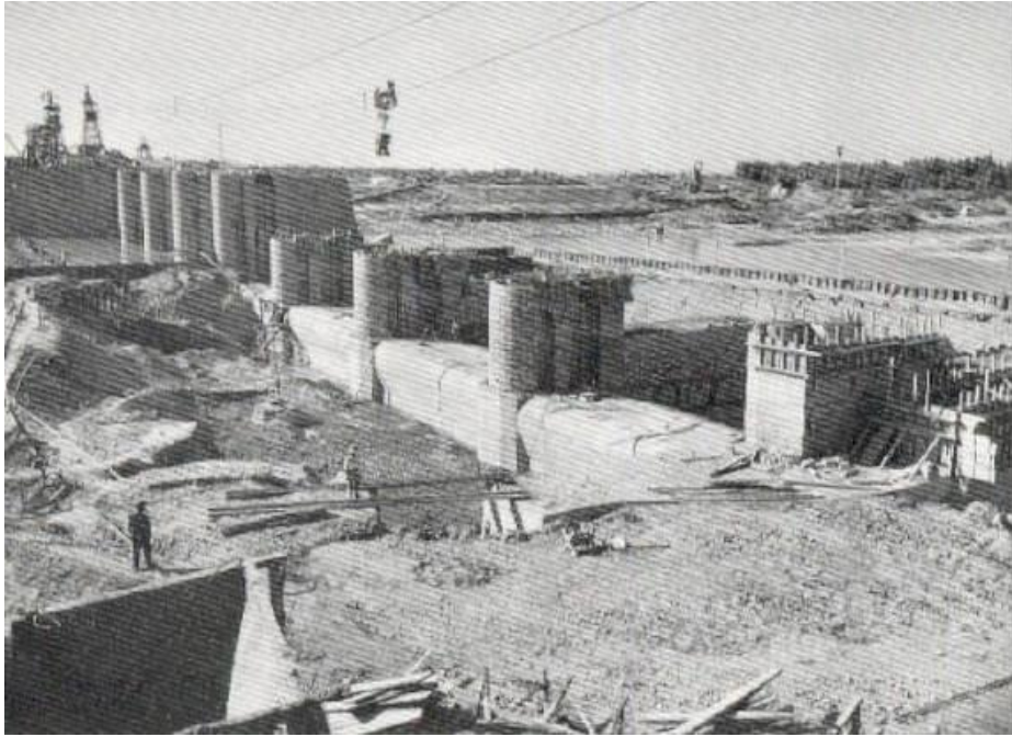
La construcción de la presa y puente entre 1953 y 1956.
