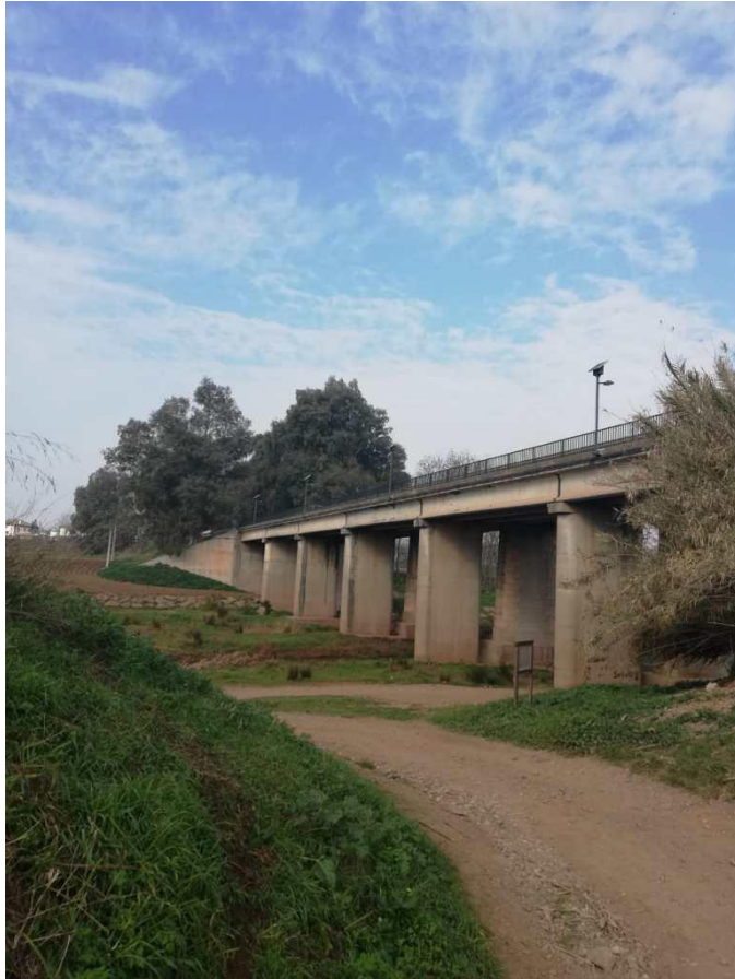
El puente sobre el Viar, se construyó antes, finalmente, en 1929.
